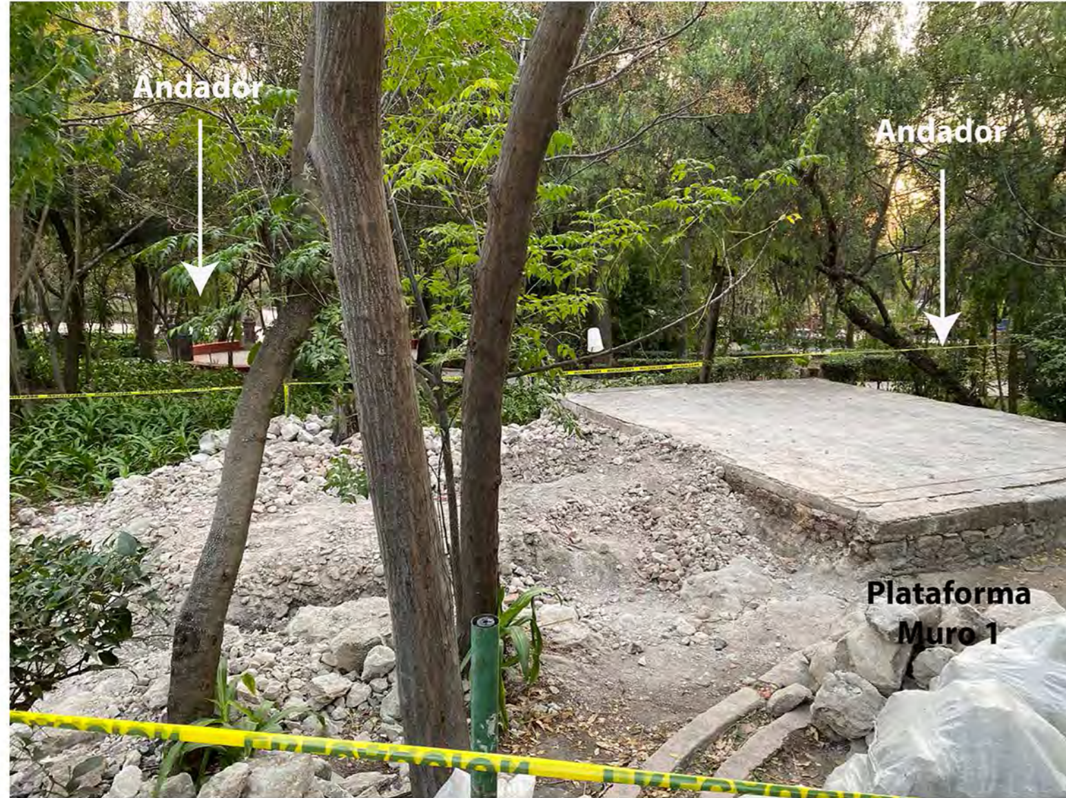
22 de Febrero 2020. Esquina sureste de plataforma. Superficie de tabique sobre mamposteo
