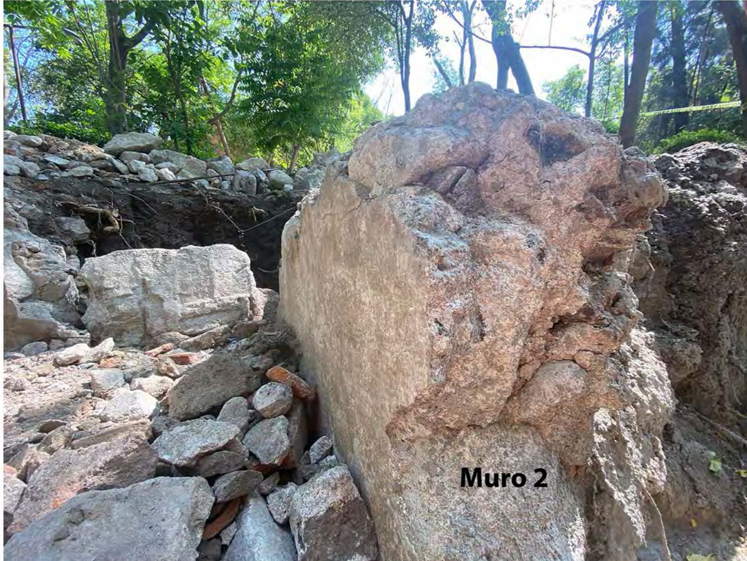
22 de Marzo 2020. Detalle de muro, mortero y acabado. Mezcla de materiales pétreos, arena, cal y agua. Acabado pulido con el mismo mortero de arena y cal con un espesor de entre 0.5 y 1 cm. El transporte de la piedra requirió un enorme esfuerzo. Pudo venir del arroyo que atraviesa el mismo parque.
