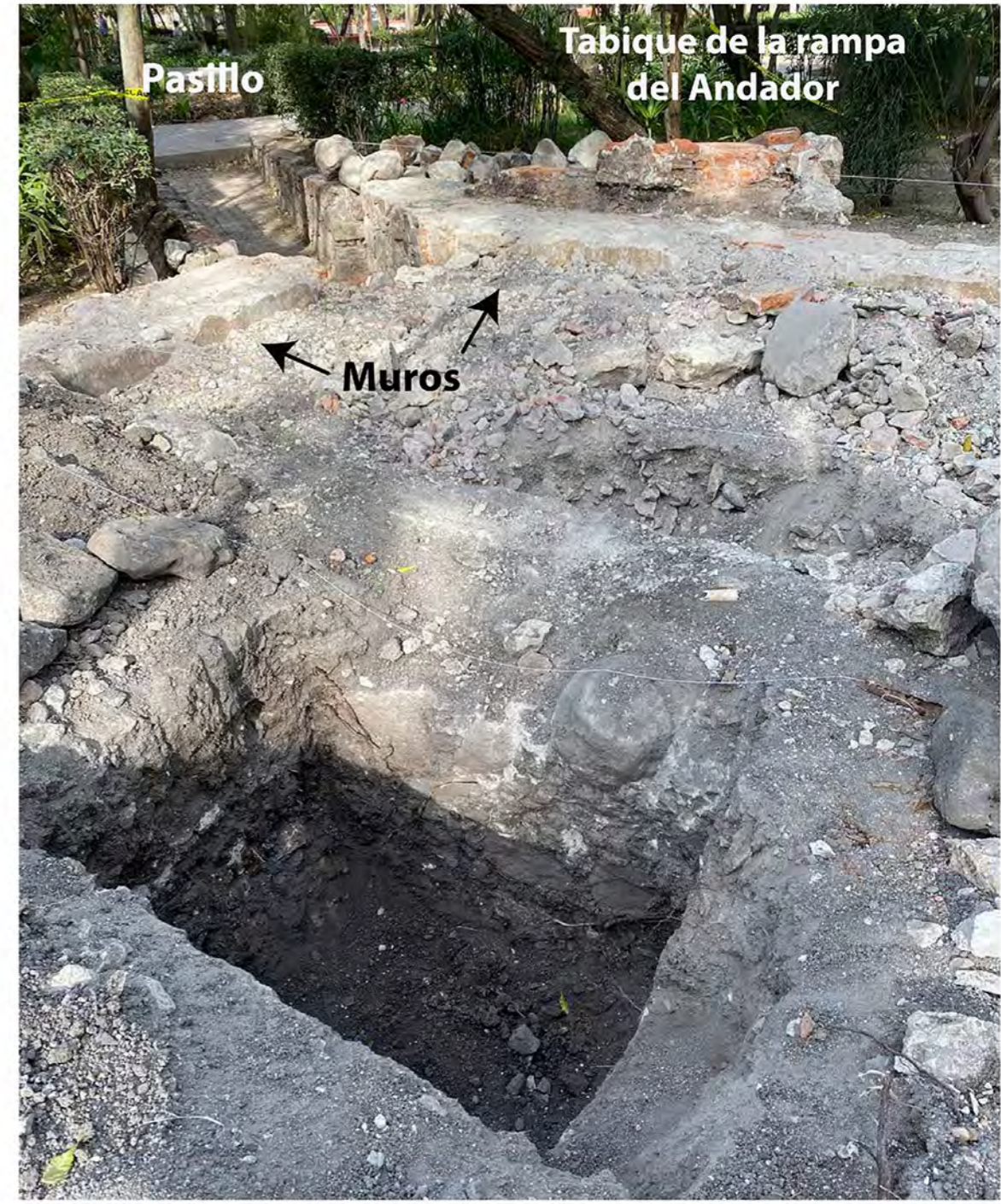
4 de Marzo 2020. Pozo para zapata. Visual Poniente con pasillo de acceso.
