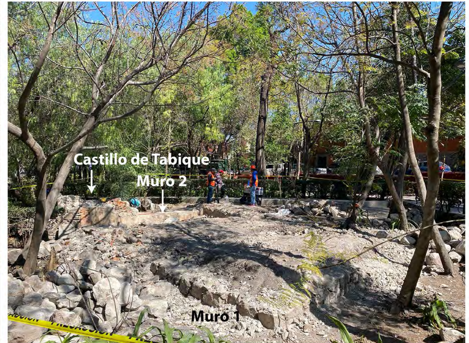
28 de Febrero 2020. Esquina sureste de plataforma. Al retirarse parte de la plataforma aparece el Muro 2, visible al fondo. A la izquierda se observa un castillo de tabique que fue colocado como parte de la planeación del sistema constructivo de mamposteo que daba forma al pasillo y al andador de cemento pulido rojo.
