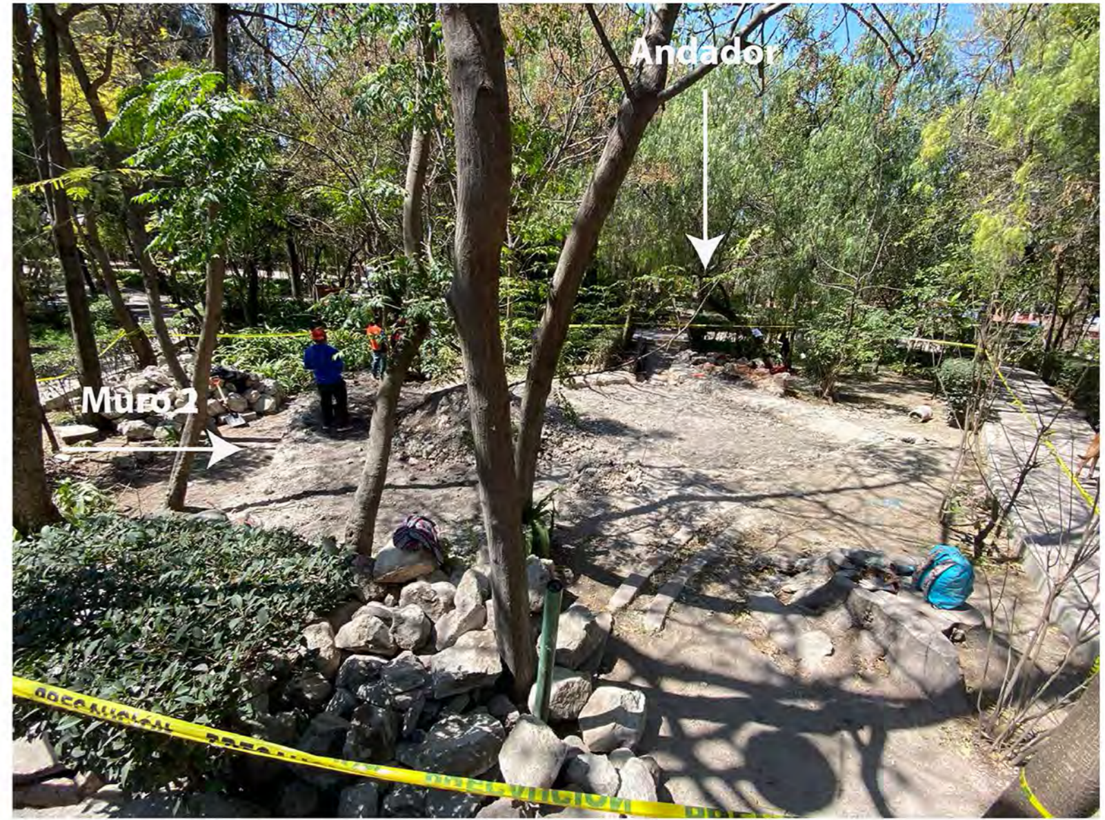
28 de Febrero 2020. Visual Sur. El trabajador se encuentra sobre el muro este.
