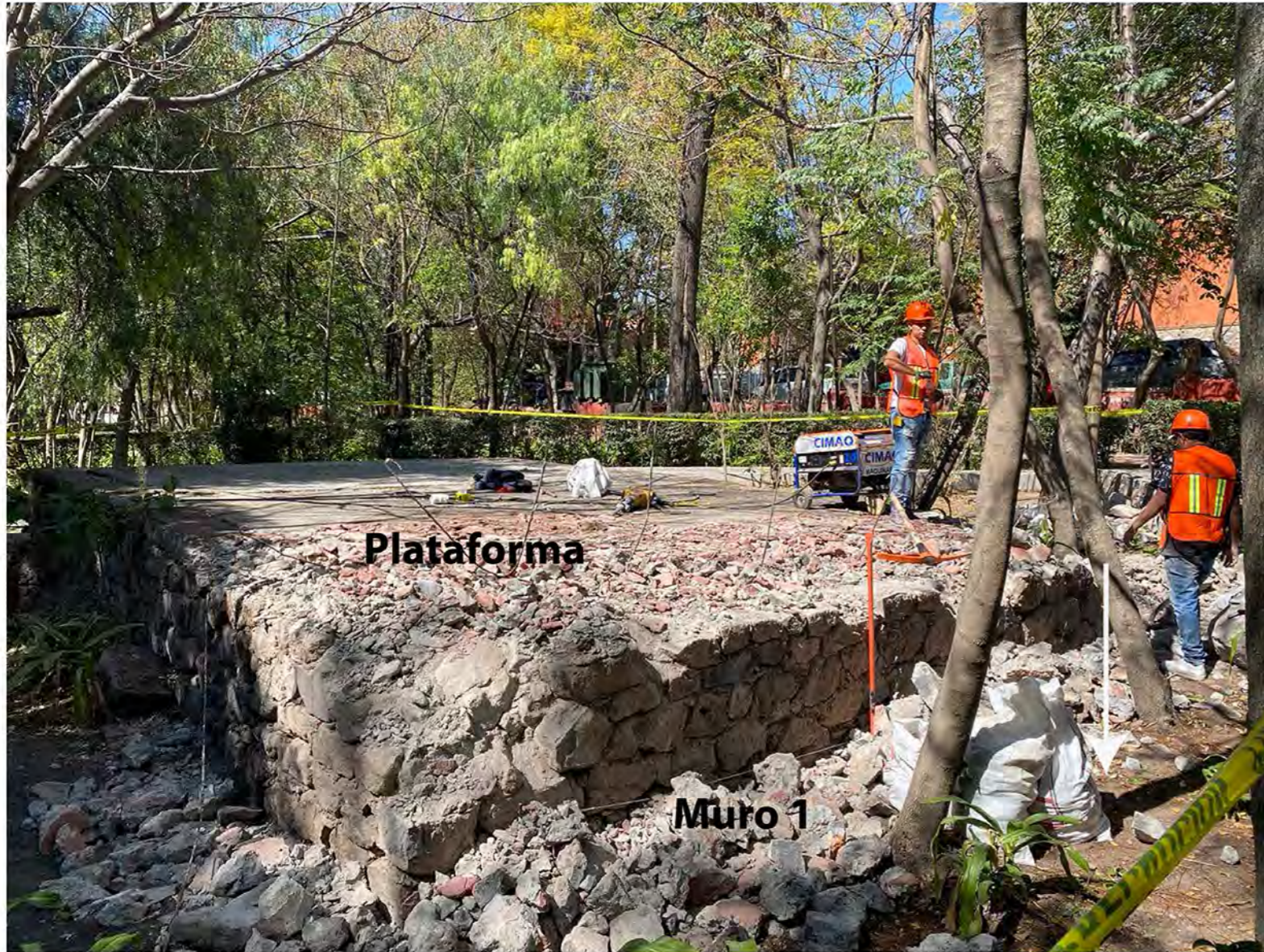
19 de Febrero 2020. Esquina sureste de plataforma. Proceso de retiro de superficie de tabique con rotomartillo. Fachadas sur y oriente de Muro 1
